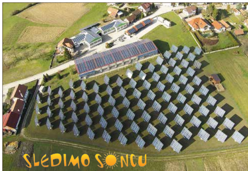
Tako se iz ptičje perspektive vidi največja sončna elektrarna z dvoosnimi sledilniki v Sloveniji.
